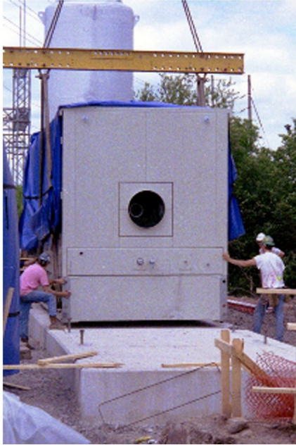
Setting the CT Unit.
