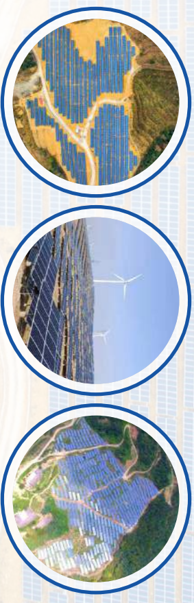
湖南省武冈市光伏扶贫项目 Poverty alleviation project in Wugang, Hunan
