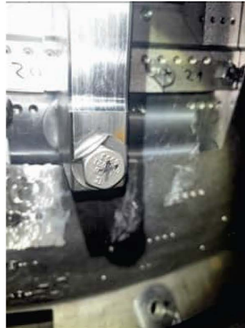
The lower inner manhole (1)
