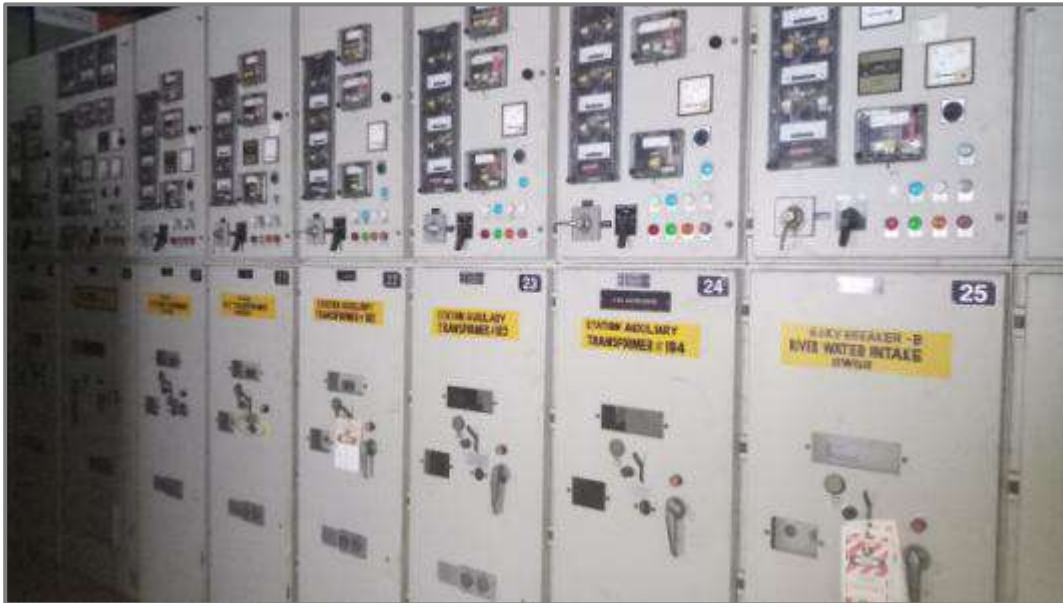
HT Switchgear
